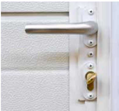
Serratura con nottolino vista interna
